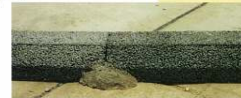
<施工例> (屋上庭園の暗渠排水)
