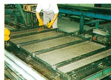
① コンクリート板の製作
